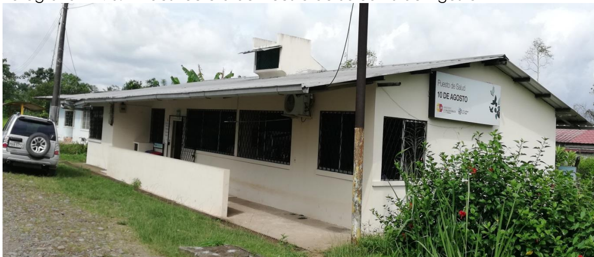
Fotografía N° 70. Infraestructura del Puesto de Salud 10 de Agosto
