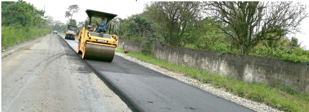
Fotografía N° 91. Colocación de capa asfáltica
