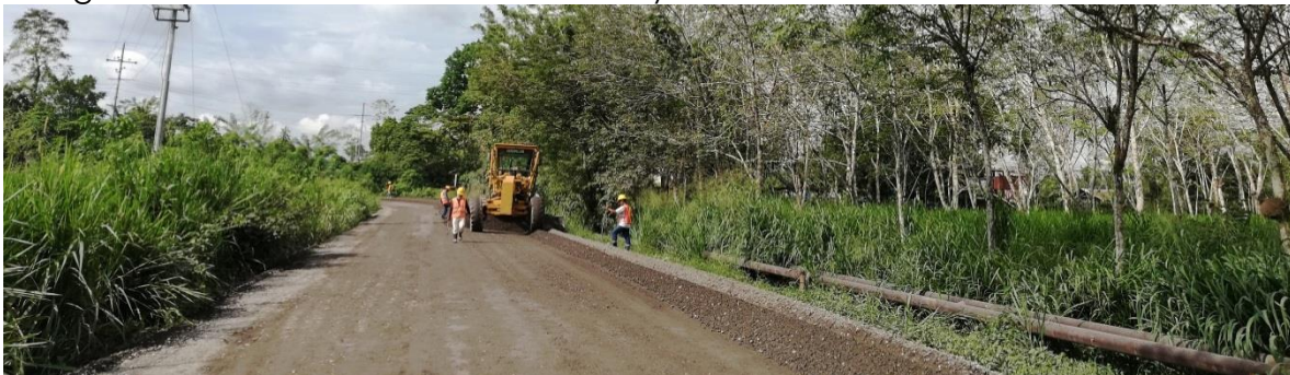
Fotografía N° 90. Colocación de la base y sub base
