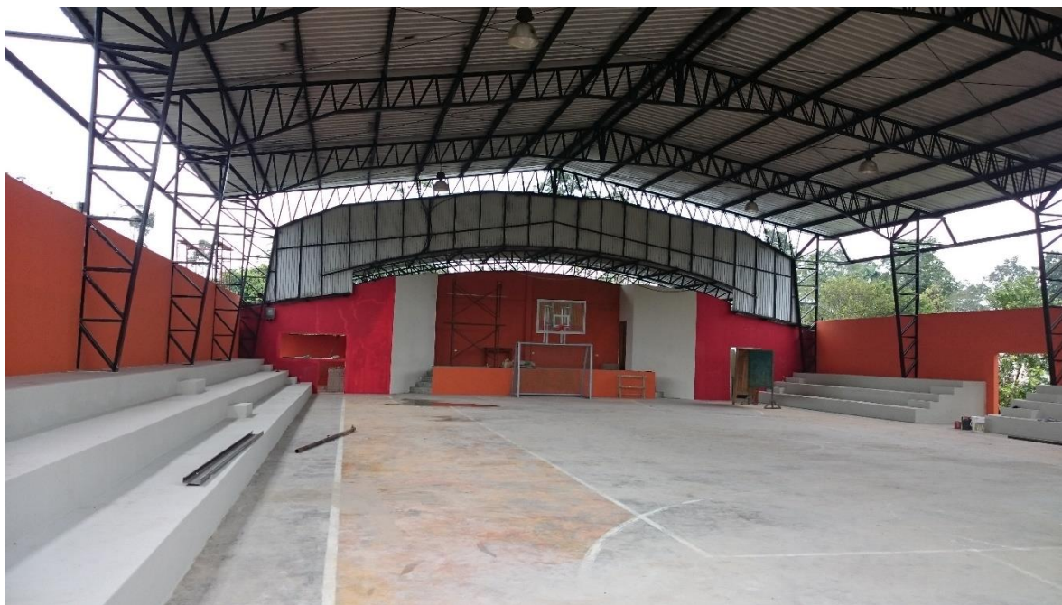
Foto 17: Cancha múltiple con cubierta en la comunidad Unión Lojana
