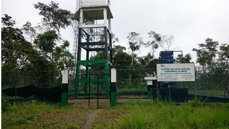
Foto 26: Sistema de agua segura
