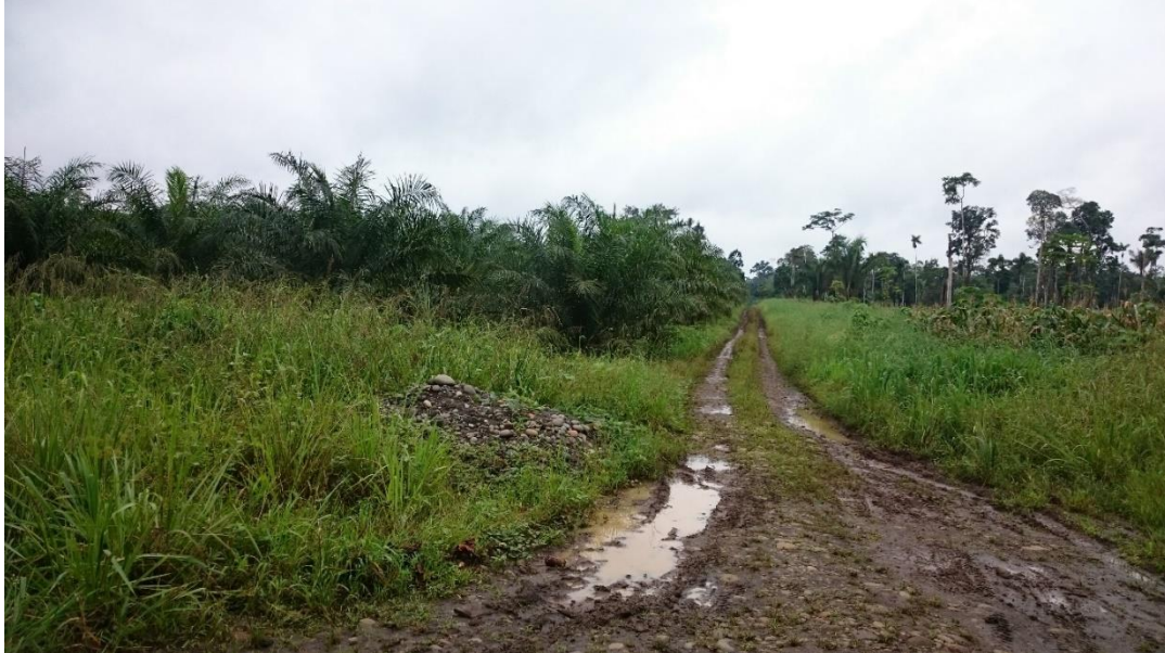
Foto 31: Camino (lastre mal estado) vía a la comunidad Huamayacu
