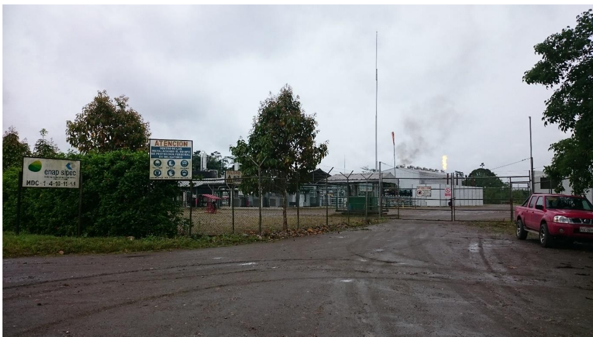
Foto 13: Chimeneas de los pozos petroleros
