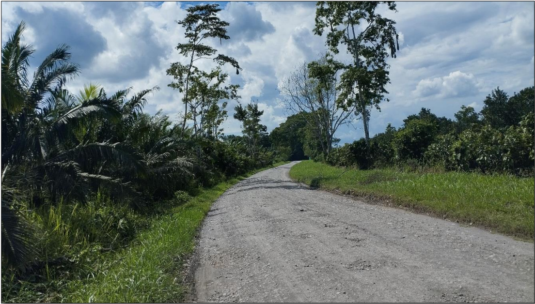
Figura 59 Vía de lastre en Unión Milagreña
