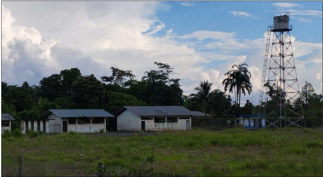
Tanque elevado de agua tratada
