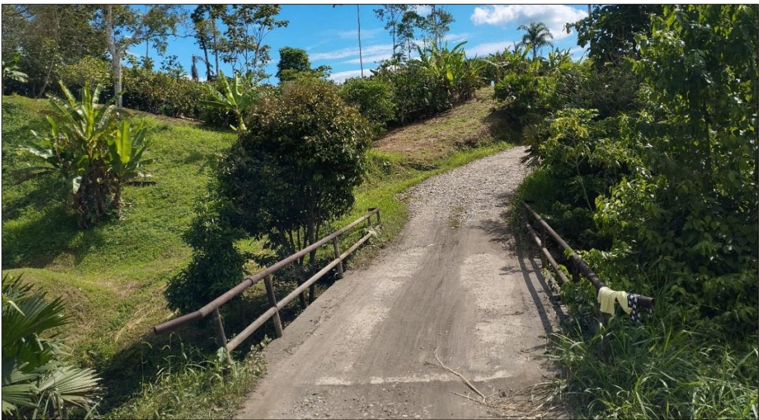
Figura 60 Vía mixta (tierra-lastre) en Unión Milagreña
